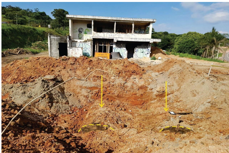
Figura 6.1. Tanques enterrados indicados pelas setas em amarelo.
