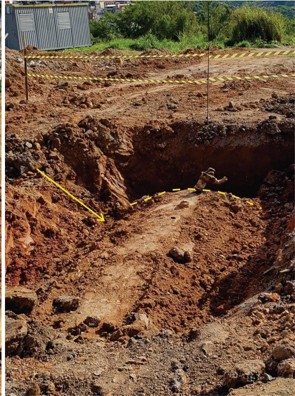
Figura 6.3. Tanques enterrados indicados pelas setas em amarelo.
