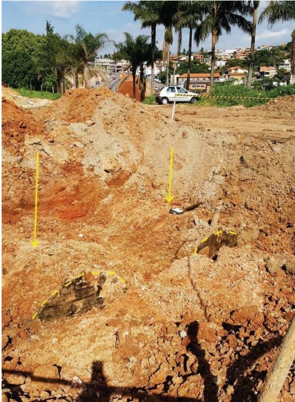
Figura 6.2. Tanques enterrados indicados pelas setas em amarelo.
